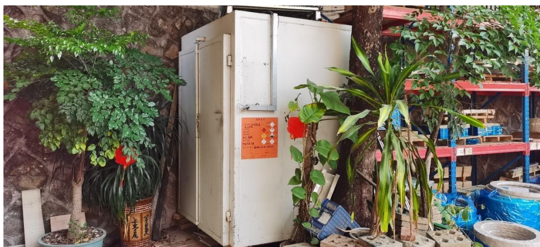
图 4.1-3 危废暂存间图
