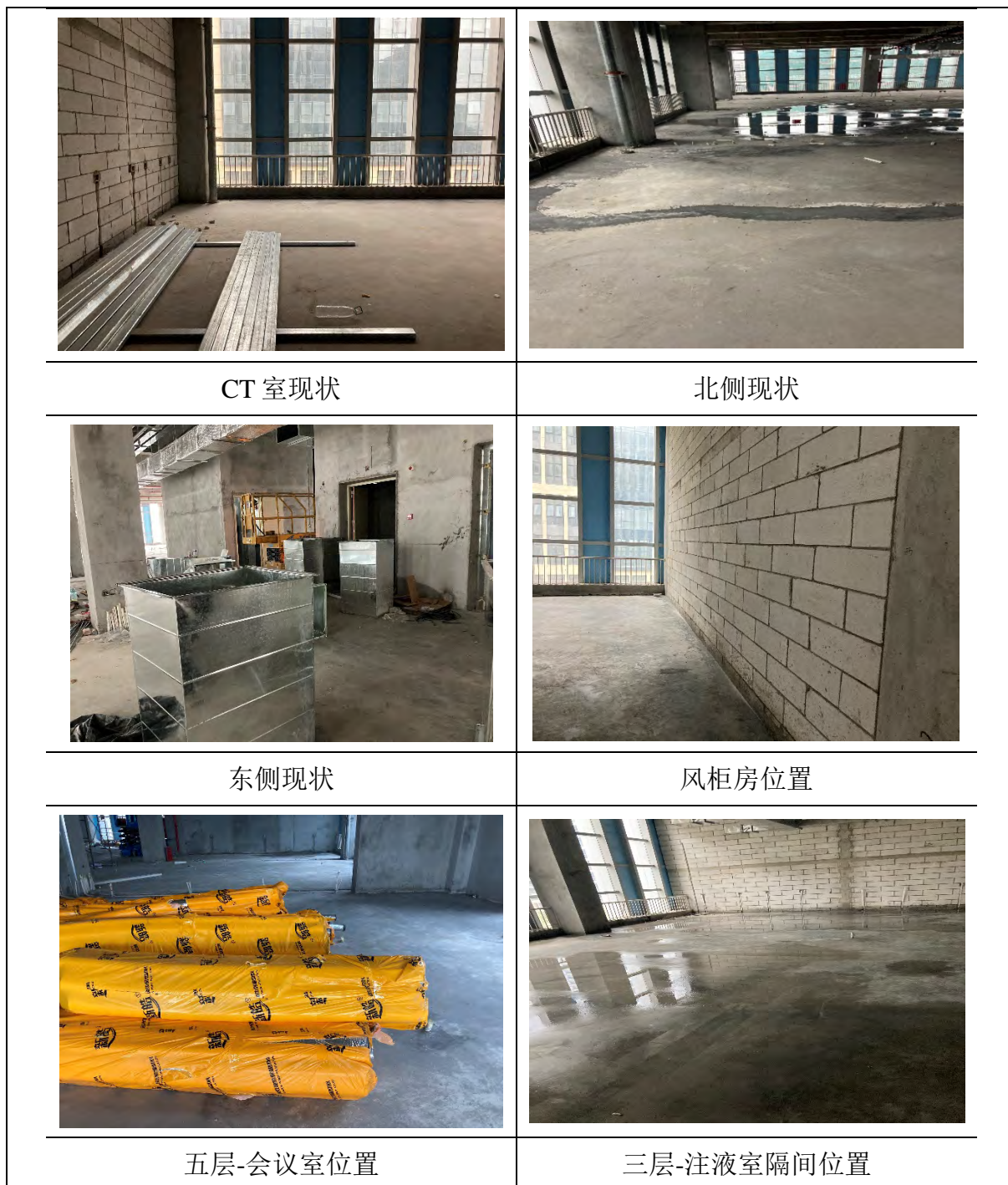
图 8-2 场址现状照片
