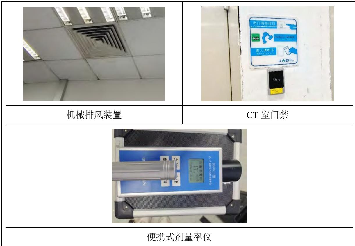
图 4-2 辐射安全与防护设施实物图
