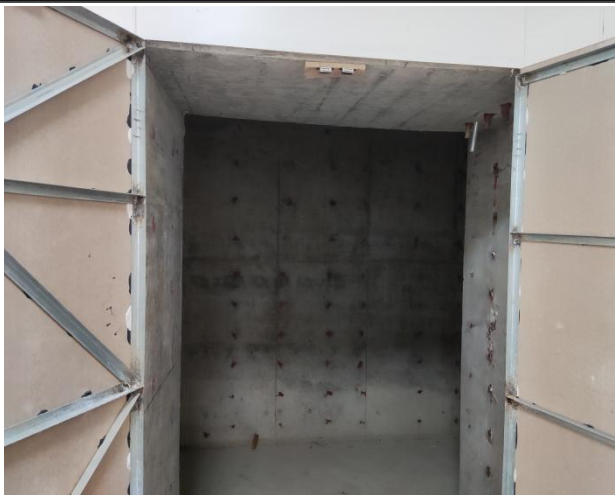
1#直线加速器机房（南白象院区）
