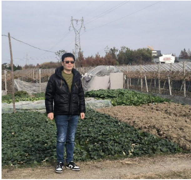
220kV 跃海 2435 线#11~#14 段改迁工程线路起点处
