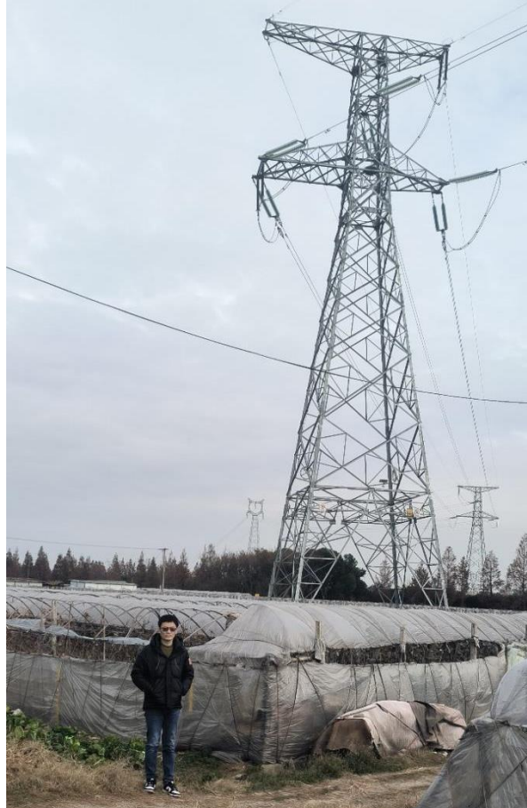
220kV 跃海 2435 线#11~#14 段改迁工程线路终点处
