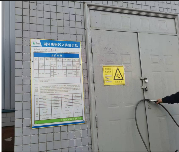
图16 危废暂存间外部
