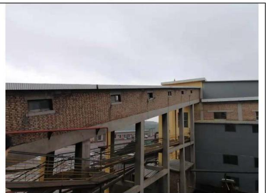
皮带输送全封闭
